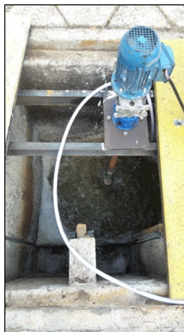
Figura 7. Ponto de dosagem e agitador mecânico
